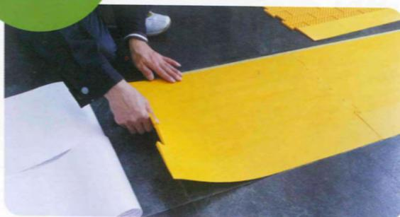
既存の床の上に両面テープで貼るだけで誘導路が完成します。床を剥がす工事が不要ですので、イベント会場などでの仮設利用や、改装による誘導路変更などにも柔軟に対応可能です。
