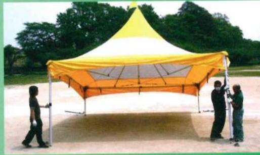
4 下部足フレームジョイント、ターンバックルによる強度調整。足フレーム垂直・平行の調整。
