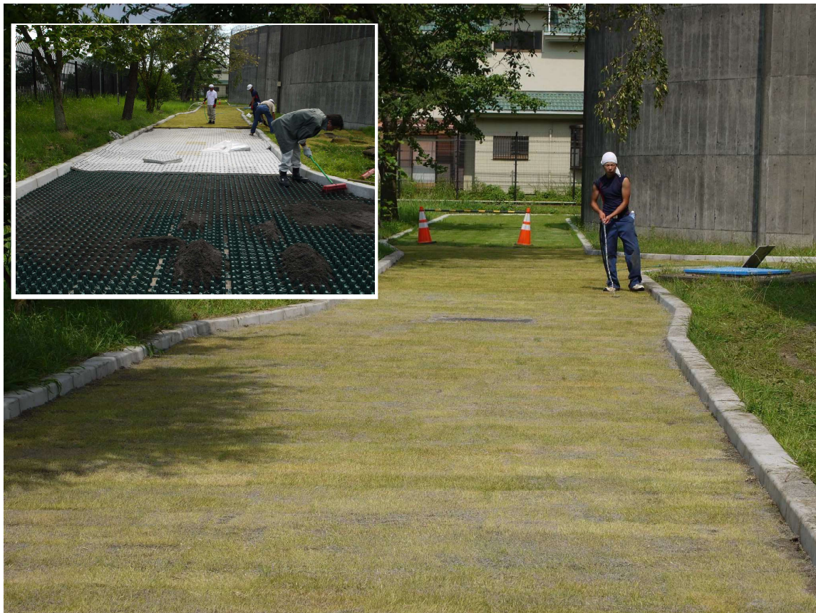
立川市役所砂川浄水場
