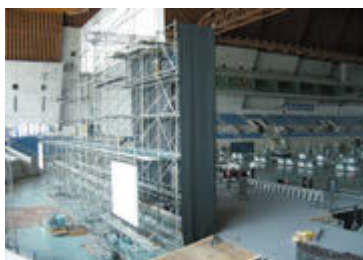
▲パネル用架台・スロープ設置
