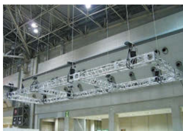
▲照明用トラス・モータ吊り
