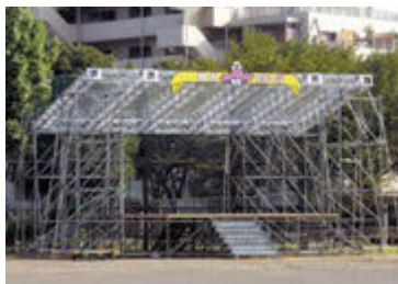
▲モデックスシステムにてトラスルーフ取り付け▲
