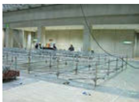
支柱・つなぎ・平台受け施工
