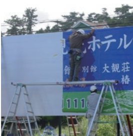
仕上げシート貼り
