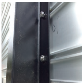
支柱とパネルのボルト止め
