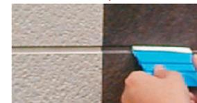
目地等への圧着はプラスチックスキージを上から押し付けるように動かします。フィルムの追従性が足りない場合は、ヒートガン等を使用し加熱圧着をします。
