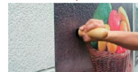
リベットブラシ等を用い、凹凸部分に追従させます。特に端部は念入りに圧着します。
